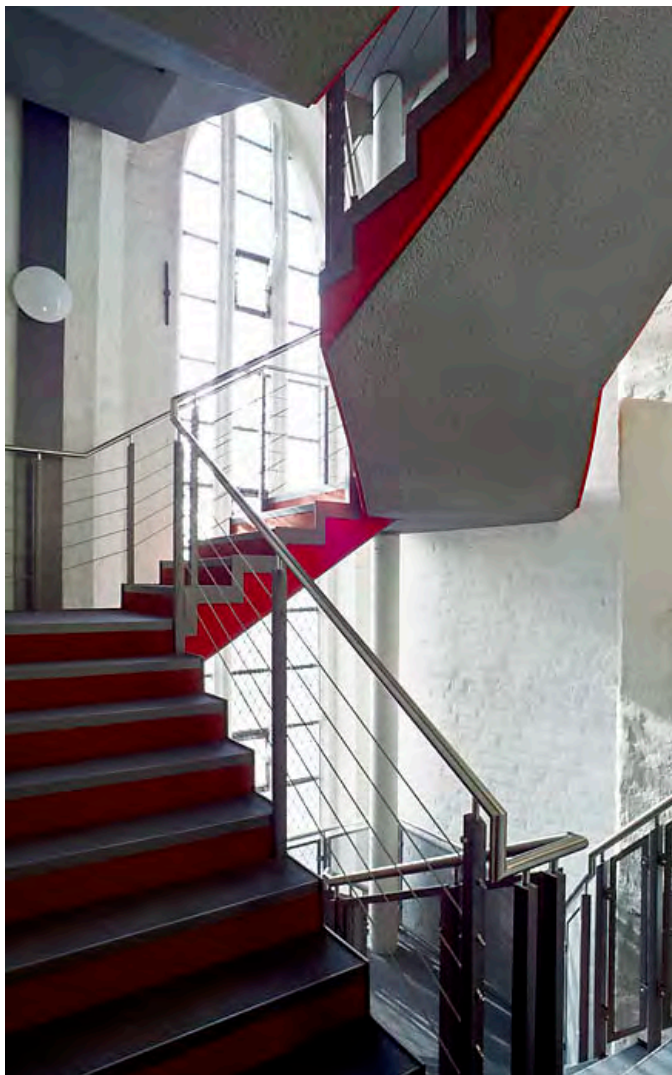
Einfügung eines neuen Treppenhauses als zweiter Rettungsweg
