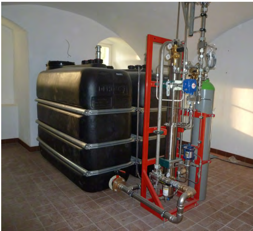
Hochdruckwassernebellöschanlage
