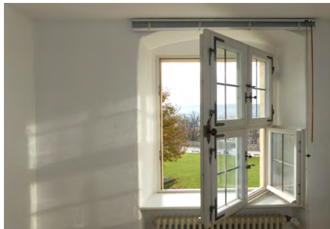
Rettungsfenster in geöffnetem Zustand
