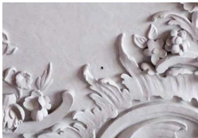
Detailaufnahme Rauchansaugsystem
