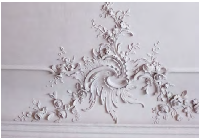
Kaum sichtbare Öffnung eines Rauchansaugsystems
