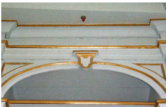
Löschdüse einer Hochdrucknebellöschanlage
