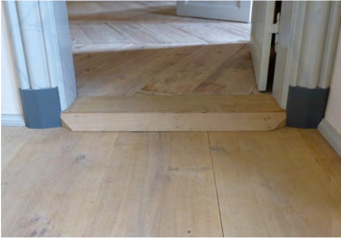
Barrierefreie Rettungswegführung durch angepasste neue Schwelle
