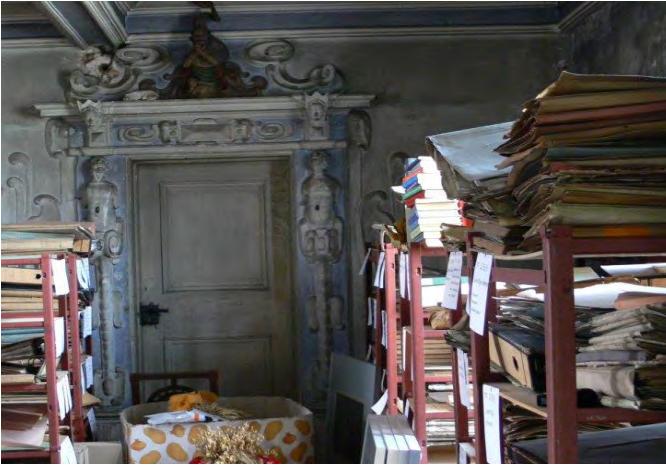
Brandlasten und verstellter Ausgang als Gefahrenquelle
