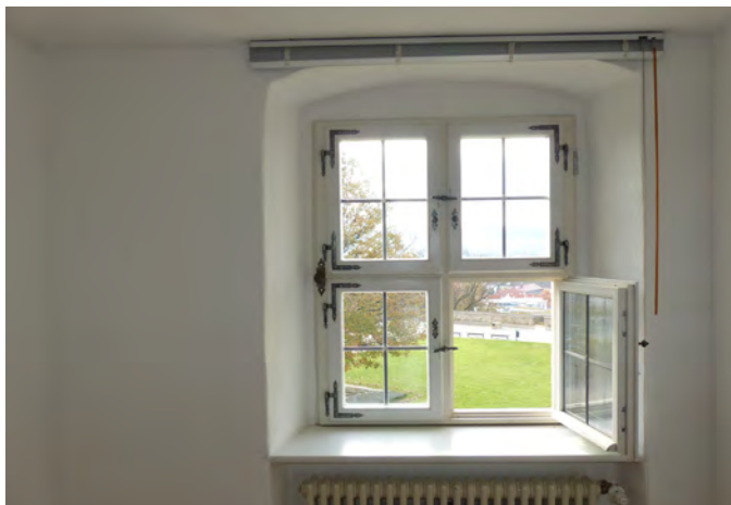
Fenster als Anleiterstelle
