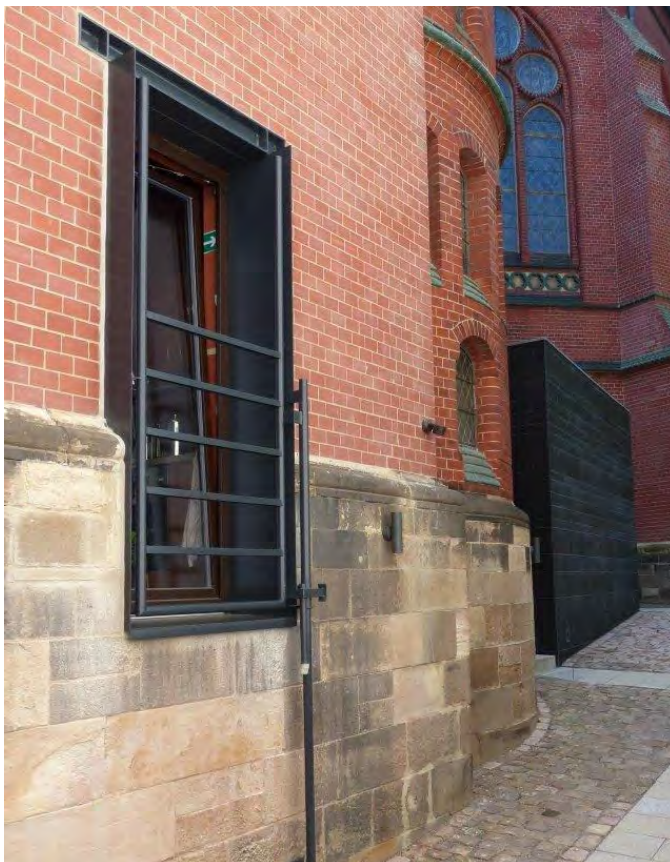
Ansprechend gestaltete Fensteröffnung
