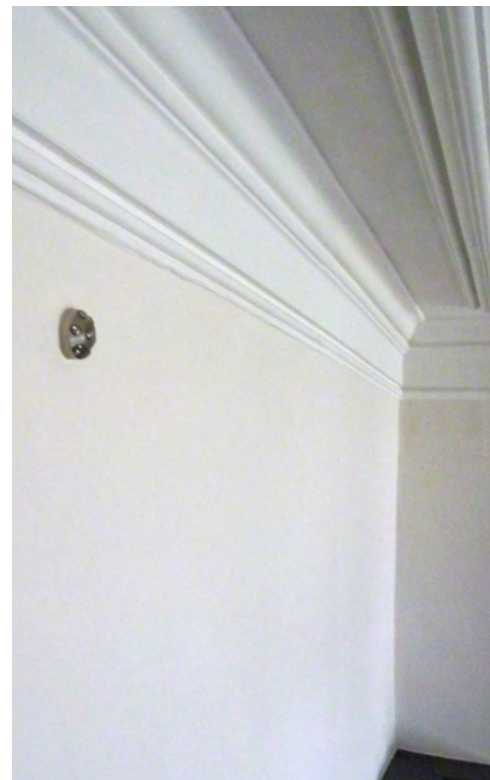
Löschdüse Hochdruckwassernebellöschanlage
