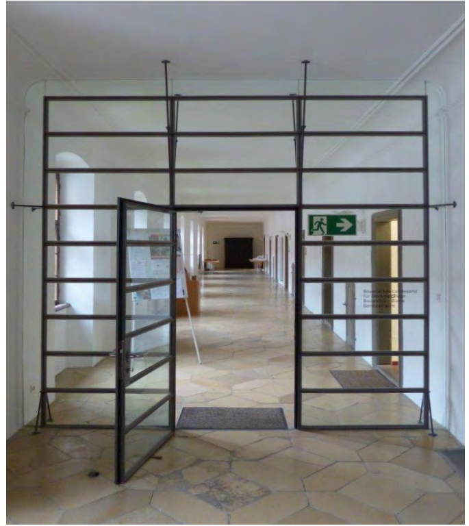
Brandabschnittsbildung innerhalb eines öffentlichen Gebäudes
