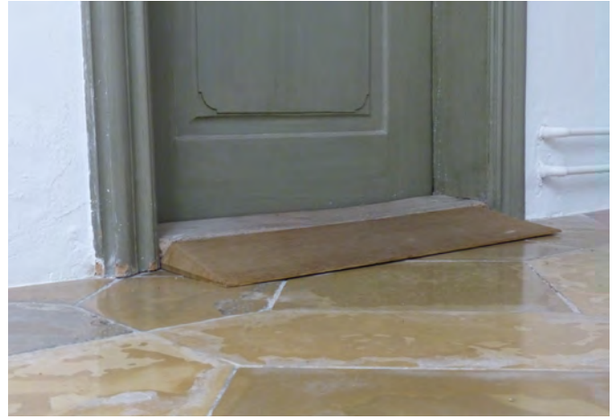
Barrierefreie Rettungswegführung durch hinzugefügten Keil
