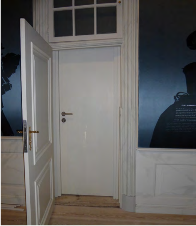
Feuerschutztür mit Zustimmung im Einzelfall (ZiE)
