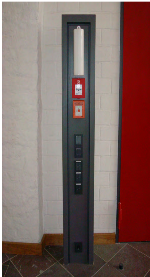
Stele mit Elektrofunktionen, einschliesslich Brandmelder
